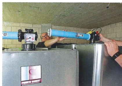
Einfacher und schneller Austausch eines Öltanks.
